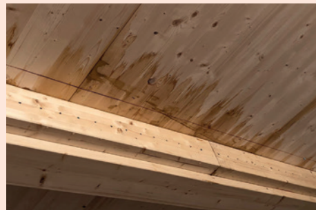
Bauschaden durch Feuchtigkeit
